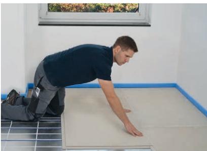
Das Element entlang des Stufenfalz fest andrücken. Der Kleber quillt leicht aus der Fuge hervor.
