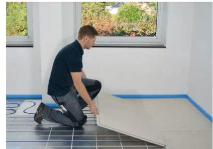
Das Element auf den Stufenfalz in die richtige Position schieben. Hautbildung des Klebers: ca. 4 Min. (innerhalb der Zeit die Stufenfalz zusammenkleben).
