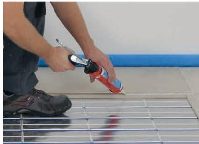
Die erste Klebeschneur nahe der Innenkante, zweite Klebeschneur im letzten Drittel des Stufenfalz gleichmäßig auftragen (ca. 5 m<sup>2</sup>/Kartusche).
