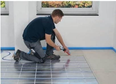
Mit Reststück ( $\geq 20$  cm) im schleppenden Verband beginnen (Fugenversatz  $\geq 20$  cm). Stufenfalz mit zwei Klebeschneiden ( $\varnothing$  ca. 5 mm) versehen.
